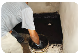
Aplicación de la primera capa de emulsión y luego el VP
