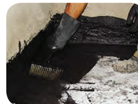
Aplicación de la segunda capa de emulsión sobre VP.
