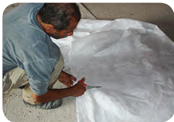
Limpieza del área y medir la zona a instalar el VP
