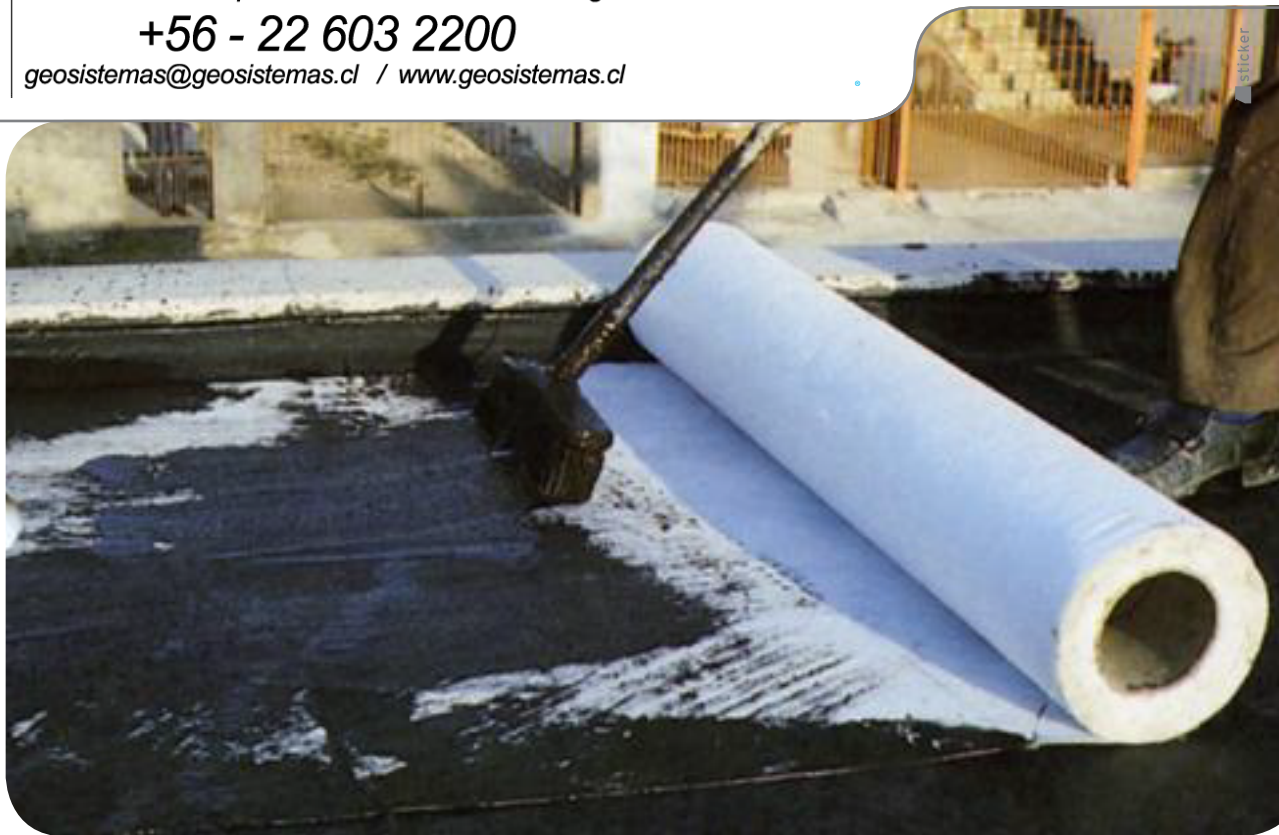
Aplicación de la primera capa de emulsión y luego el VP
